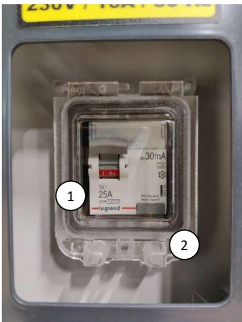
Die Fehlerstrom-Schutzeinrichtung (RCD) oder der FI-Schalter (1) muss nach oben gelegt sein, damit alle 230 V-Geräte, einschließlich der 230-V-Steckdosen auf der Plattform, funktionieren. Der FI-Schalter kann durch Drücken der TEST-Taste (2) am Gerät getestet werden. Lässt sich der Schalter am Gerät nicht umlegen, liegt entweder ein Defekt am Gerät vor oder das Anschlusskabel ist nicht mit dem Netz verbunden.
